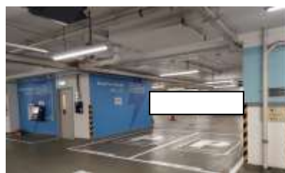
No. 78 & 79, Floor L3 of Phase 4 四期停車場 L3 樓層 78 及 79 號車位
