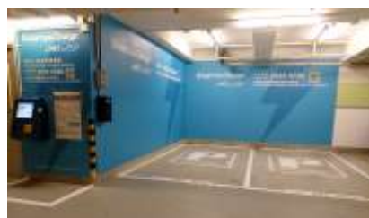
No. 231 & 232, Floor CP1 of Phase 1 & 2 一期及二期停車場 CP1 樓層 231 及 232 號車位
